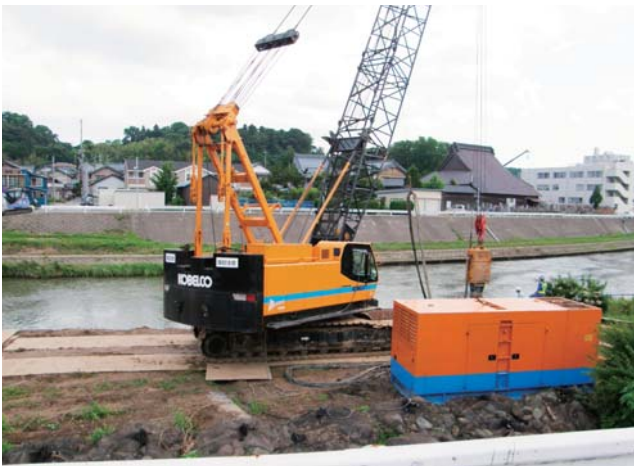
河川区域工事現場での抜取調査の一場面
