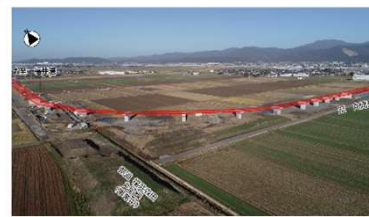
福井港丸岡インター連絡道路
