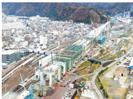
【敦賀駅高架橋】
