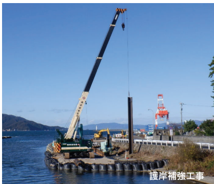
【河道掘削・護岸補強：筥の川(3億2,200万円)】
