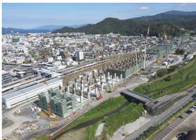
【敦賀駅高架橋】
