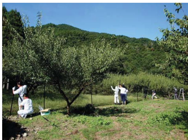
【侵入防止柵の設置作業】
