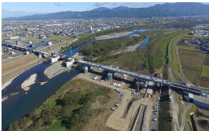
【九頭竜川橋梁工事】
