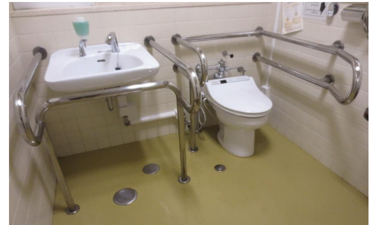
【多目的トイレ】
