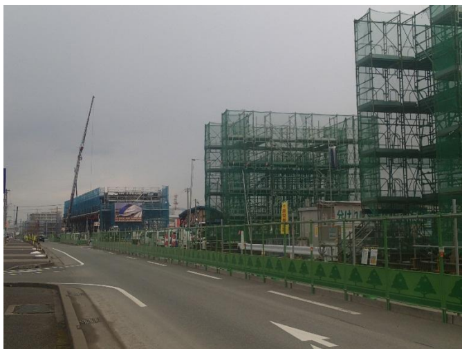
【福井高柳高架橋工事】
