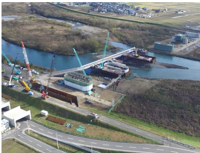
【九頭竜川橋りょう工事】
