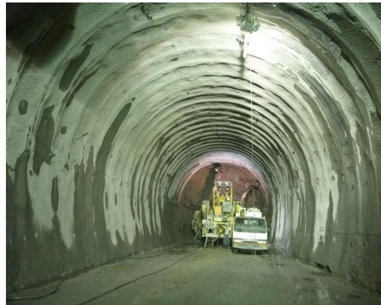
【新北陸トンネル工事(奥野々工区)】
