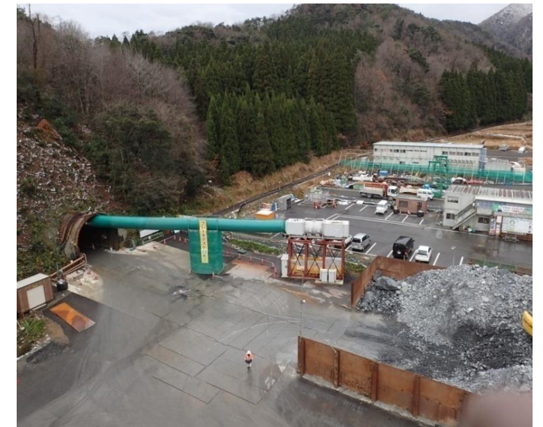
【新北陸トンネル工事(葉原工区)】
