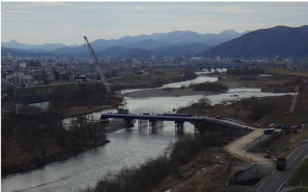
【九頭竜川橋りょう工事】
