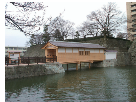
【 御廊下橋周辺 】
