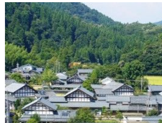
【越前町江波の伝統的民家】
