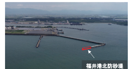
福井港北防砂堤
