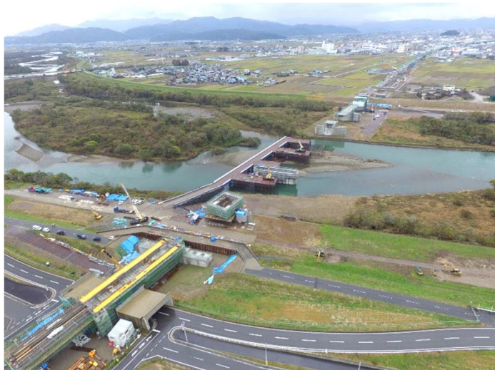
【九頭竜川橋りょう工事】
