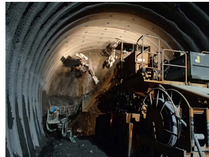
【新北陸トンネル工事（楳曲工区）】
