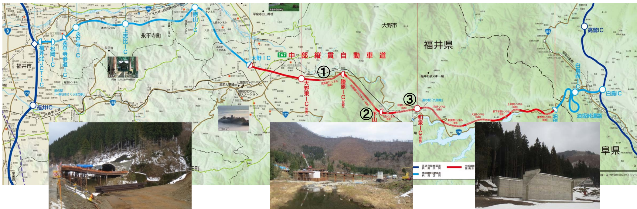
【①荒島第1トンネル(仮称)付近(大野市下唯野)】
