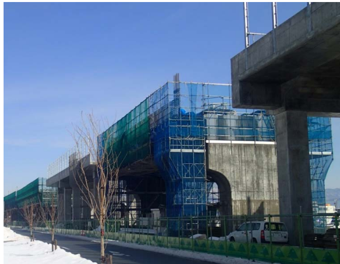
【福井高柳高架橋工事】
