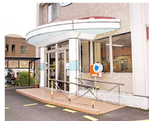
【小規模商業施設の段差解消】
