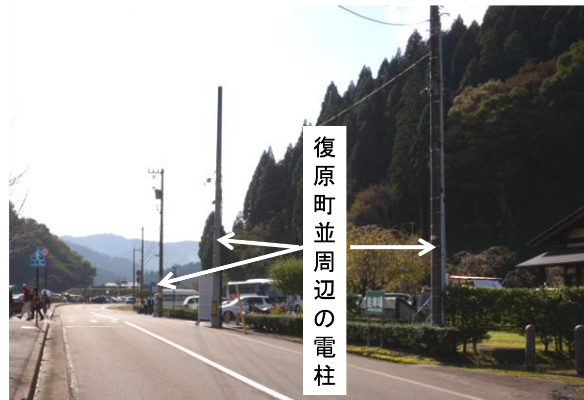
【 無電柱化する上城戸跡までの区間】
