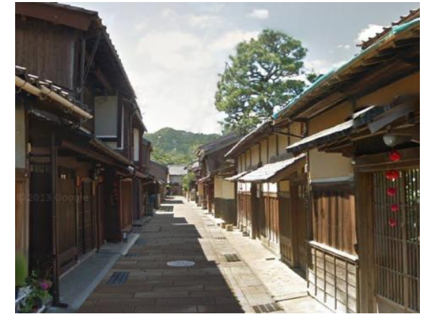
【三丁町無電柱化(小浜市)】
