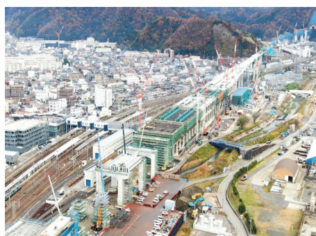
【敦賀駅高架橋】
