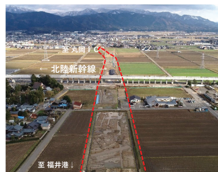
福井港丸岡インター連絡道路 【北陸新幹線交差部付近(坂井市丸岡町長崎)】
