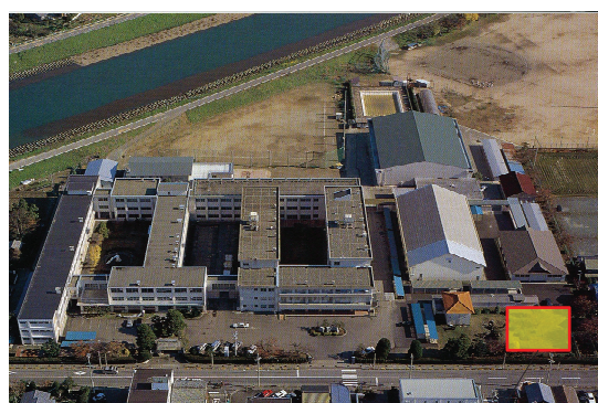
寮建設予定地
