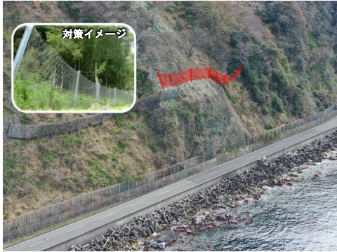
一般県道大谷杉津線（しおかぜライン） （落石防護柵工 1億400万円）
