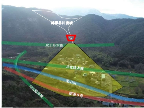
たすきたにかわ 綿襷谷川（敦賀市鳩原） （通常砂防事業（砂防堰堤）1億1,600万円）
