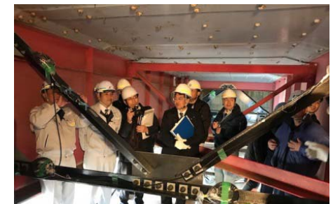
炭素繊維複合材料を用いた老朽橋梁の補強技術開発
