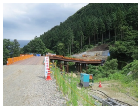
【荒島第1トンネル(仮称)付近(大野市下唯野)】
