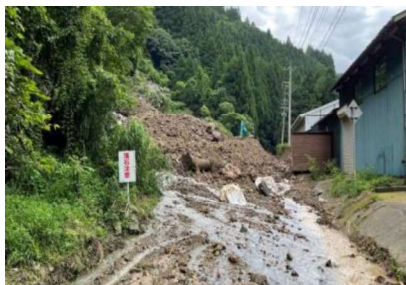
【福井四ヶ浦線(福井市国山町)】 重力式擁壁による復旧
