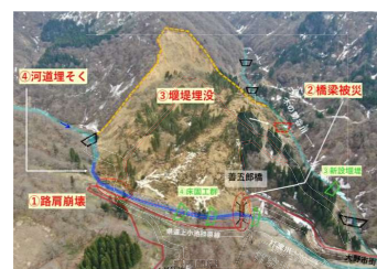
【令和5年3月融雪被害(大野市)】
