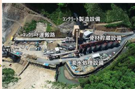
現場内プラント(コンクリート製造設備)
