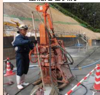
基礎処理状況
