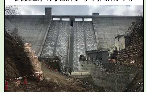
試験湛水の状況(参考:河内川ダム)
