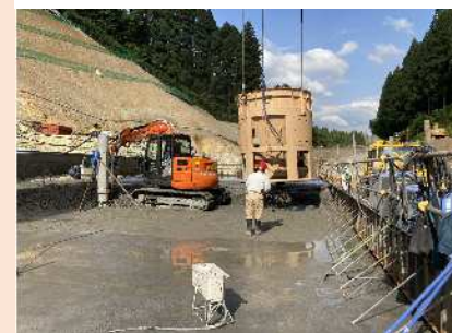
コンクリート打設状況
