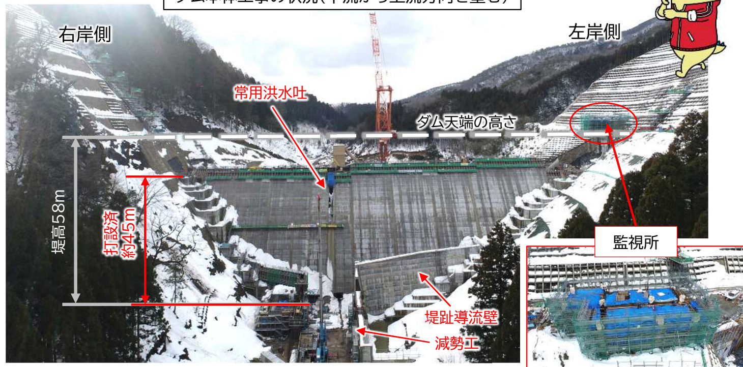
ダム本体工事の状況（下流から上流方向を望む）
