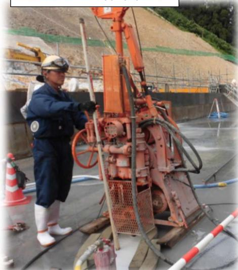
ダム堤体の上からボーリングマシンで岩盤を削孔しています
