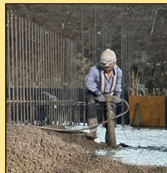
人カバイブレータによるコンクリート締固め作業
