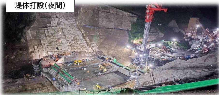
堤体コンクリートの品質確保のため暑い日中を避けて打設しています
