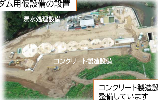
ダム用仮設備の設置
