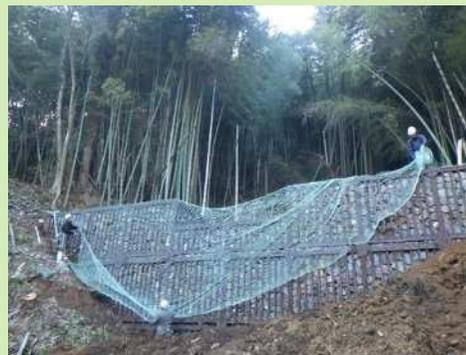
老朽化した鋼製ダムの腐食で中詰石が崩れ落ちる危険が懸念されたため、安全ネットを設置するなど、ダム崩壊を防ぎ安全に作業を進められる工夫をしました。
