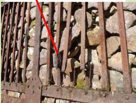
鋼製枠が腐食し詰石が落ちる危険
