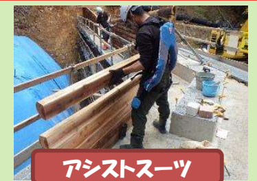
透明型枠、型枠止水テープを用いて品質向上しました。
