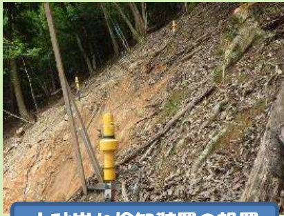
土砂崩れ検知装置の設置
