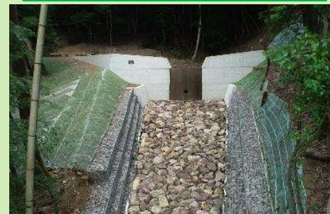
現地発生石材を用いた巨石張り
