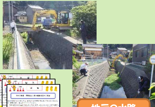
地元の水路の土砂撤去
