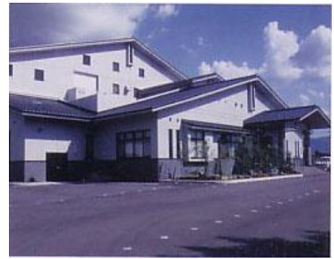
▲大野市浄化センター(大野市)
