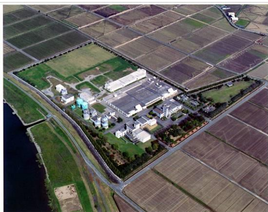
▲九頭竜川浄化センター（坂井市：流域）
