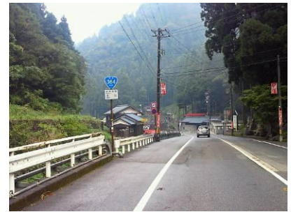
永平寺への国道（永平寺町）
