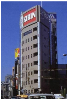
ビル外壁と同じタイルで枠を付け、一体感を出した屋上広告。 (3)
