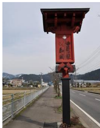
“うるしの里通り”沿いに設置された広告塔。地場産業である越前漆器の技術を応用し、本漆塗りで仕上げられています。こうした地元の技術や素材を生かすことで、産業・文化などを伝えるとともに、地域の人々に親しまれるものとなります。(鯖江市)
