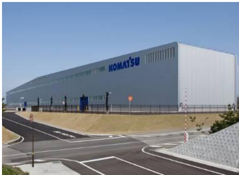
建物の屋根の流れ・色合いと広告物との調和がとれています。(石川県金沢市) (16)
