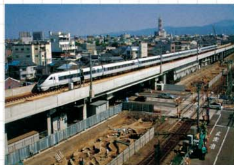
仮日之出踏切と JR北陸線の交差部の状況 (平成 18年9月)
