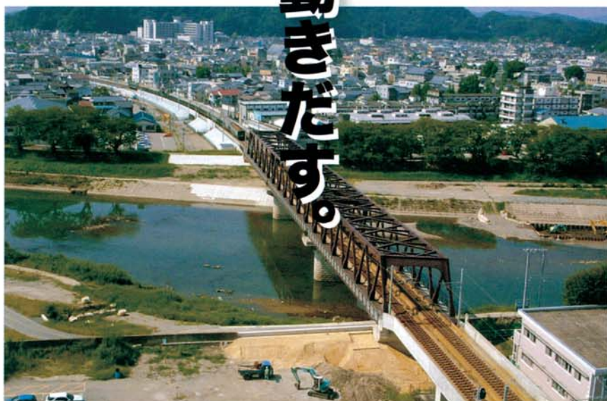
足羽川JR橋梁 (平成18年9月撮影)
