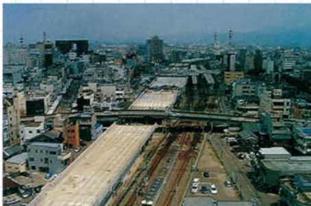
豊島跨線橋と JR北陸線の交差部の状況 (平成 15年 8月)
