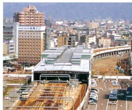
新福井駅舎の状況(平成18年9月撮影)
