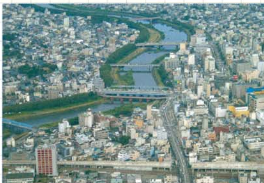
豊島跨線橋 (平成 15年7月)
