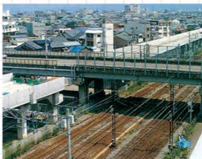
日之出跨線橋と JR北陸線の交差部の状況 (平成 15年6月)
