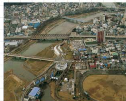
足羽川に設けた迂回道の状況 (平成 17年 3月)
