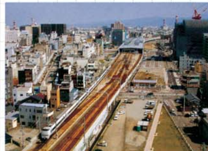
豊島跨線橋と JR北陸線の交差部の状況 (平成 18年9月)
