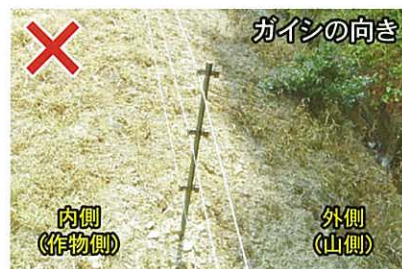
ガイシが内向きだと支柱を押し倒しやすくなるのでガイシは外向きに!
