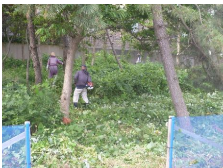
流域における下草刈り作業の様子
