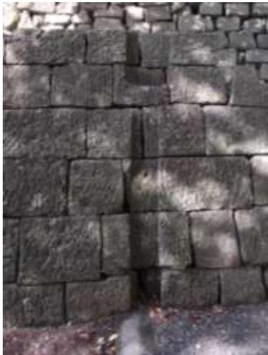
現況写真D
