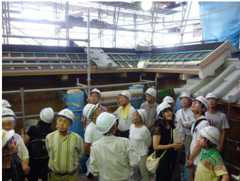
山里口御門工事説明会
