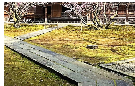
（事例）三国滝谷寺の笏谷石の床石
