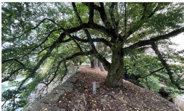
土塀上の樹木の現状
