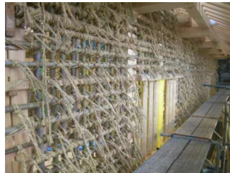
土壁の地下組み上げ
