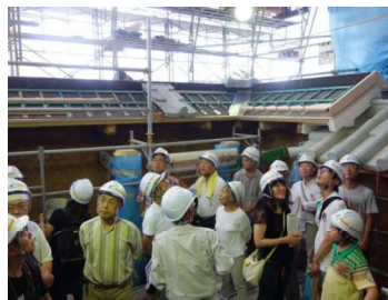
山里口御門工事説明会
