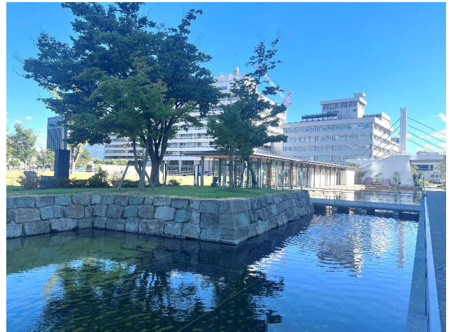
堀水景（手前）とビジターセンター御座所（奥）
