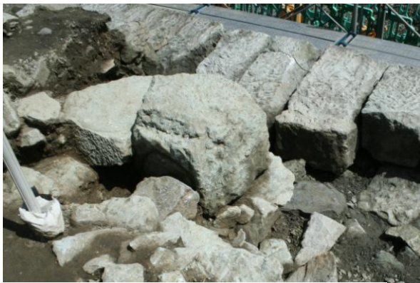
第13図 大型の裏込石 （櫓台・積み直し前の礎石？）
