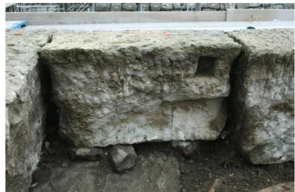
第7図 ホゾ穴のある石材 （横倒しに設置・北地区E面石垣）
