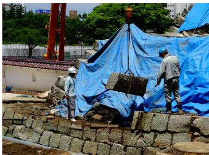
石材の据付け角度を計測後、1 石ずつ解体
