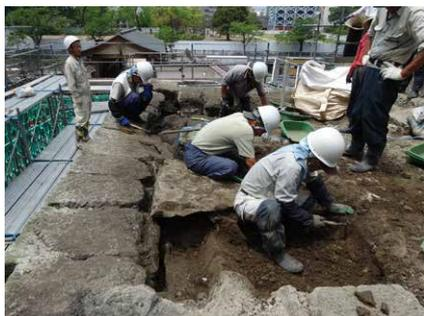
手作業による石垣盛土の掘削調査
