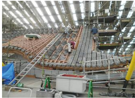
写真12 本瓦空葺き下地
