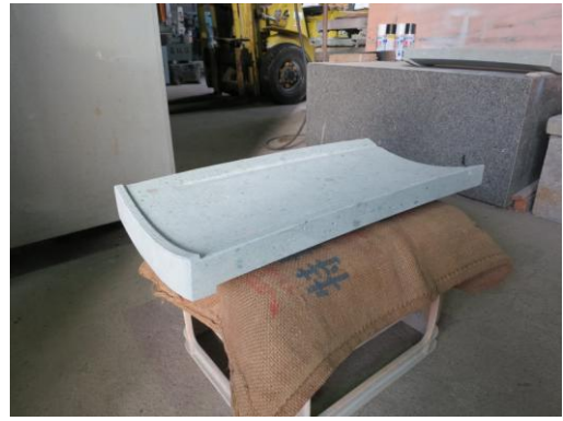
写真10 平瓦（表の水返しと裏の引っ掛け部）
