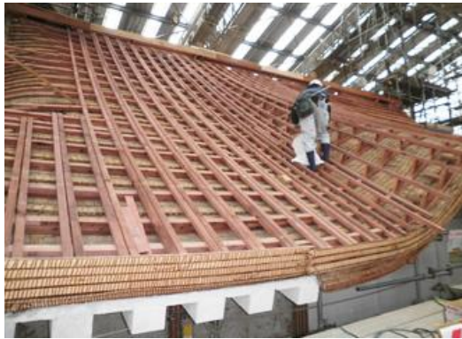
写真11 本瓦空葺き下地
