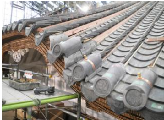
写真13 本瓦葺きの施工中
