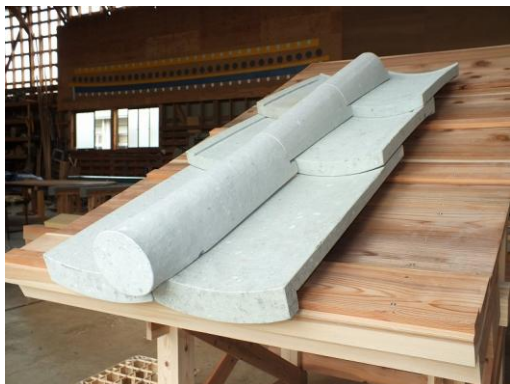
写真7 石瓦葺き (下から)
