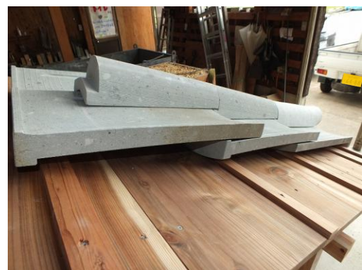
写真8 石瓦葺き (上から)
