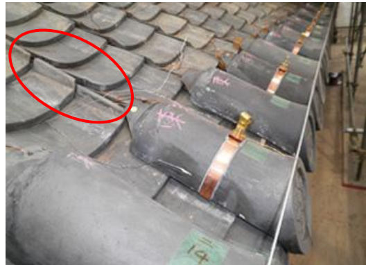
写真14 本瓦葺き平瓦の水返し
