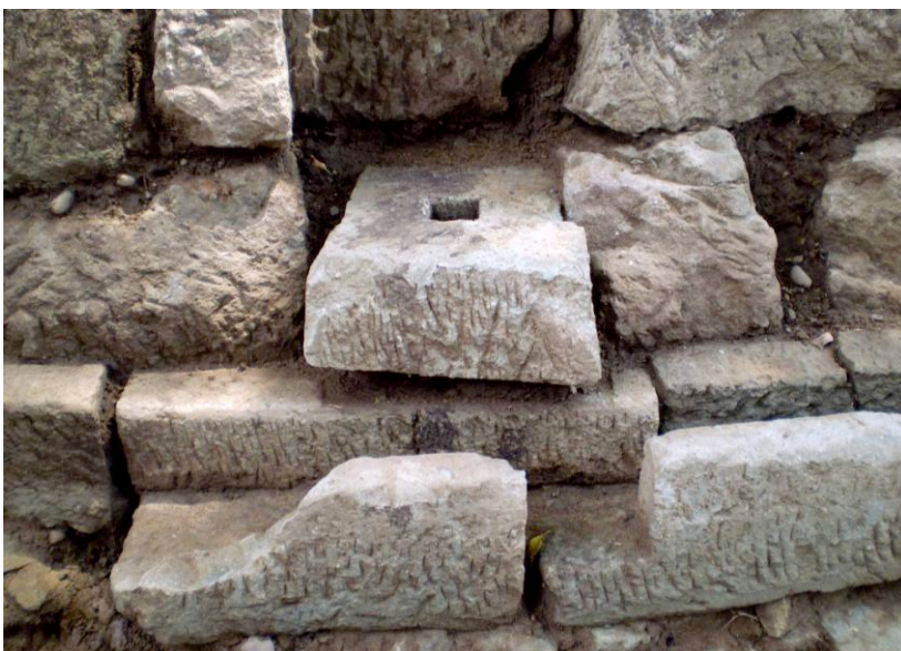
写真3 Aブロック通路部 ほぞ穴と排水路 (北より)
