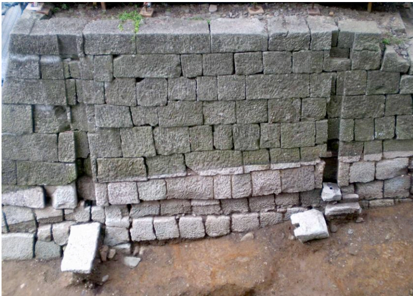
写真2 Aブロック通路部 柱受け1・3 (南より)
