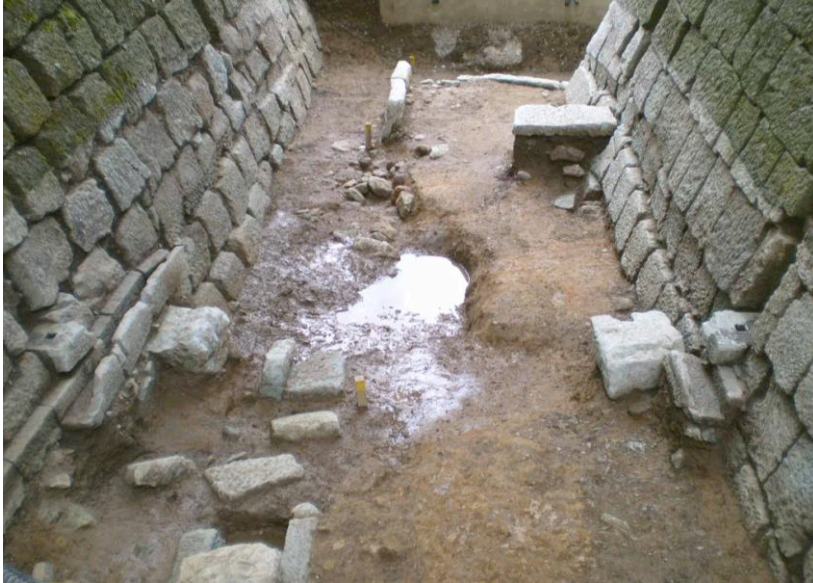
写真1 Aブロック通路部 (東より)
