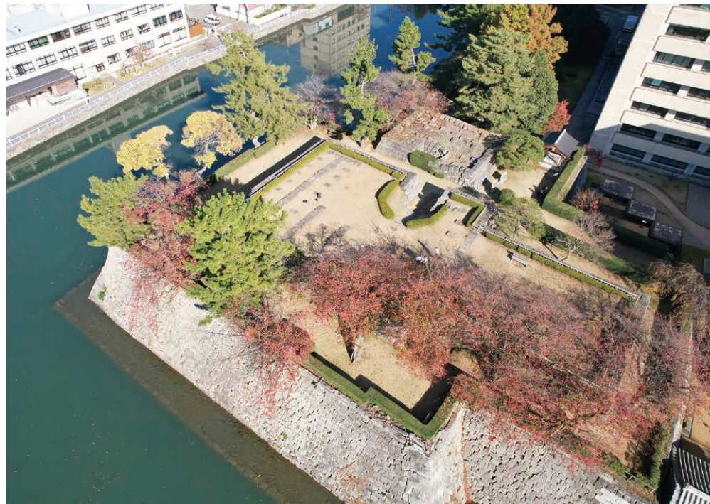
福井城本丸の北西隅にある天守台を上空から撮影
