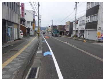
車道上の自転車通行位置明示（敦賀市）
