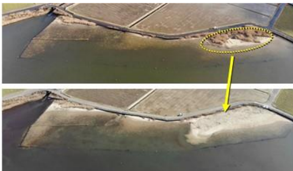
図3. 久々子湖における陸地化したなぎさ護岸の補修（令和5年2月）。
