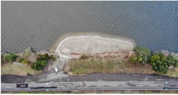
図2. 水月湖における浚渫土砂を活用したなぎさ護岸の再生（令和4年11月）。
