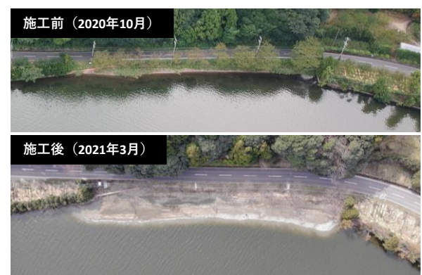
図1-b. 水月湖におけるなぎさ護岸の再生。拡大した前浜と今後発達するヨシ原は、生き物の棲みかとしてのみならず、幹線道路の浸食を軽減する効果も期待されている。水月湖でも流入河川の浚渫土砂を再利用した。
