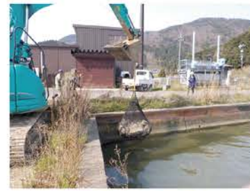
↑石倉漁礁の設置
