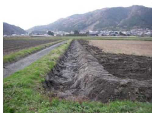
写真 3. 2-4 退避路の設置（施工後）
