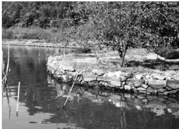
写真 3.1-1 目標設定の参考として収集する資料の例（昭和 50 年頃の石積み護岸）
