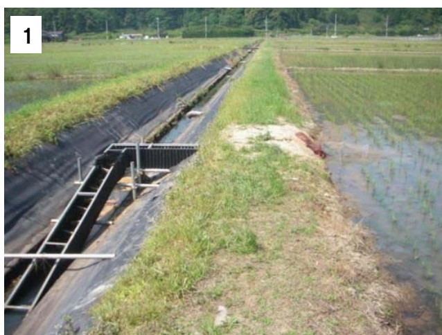
図 3.2-2 水田に設置された魚道と水田魚道
