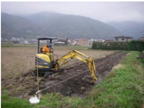
写真 3. 2-3 退避路の設置（施工中）
