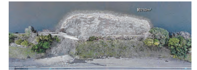
浚渫土砂を投入し、重機で整地した様子(水月湖)
