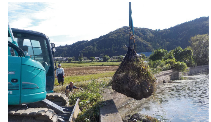
重機を用いコンクリート護岸沿いにネットにいった石を設置
