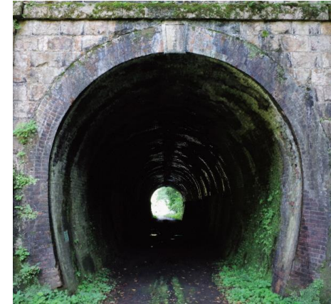
旧北陸線トンネル
