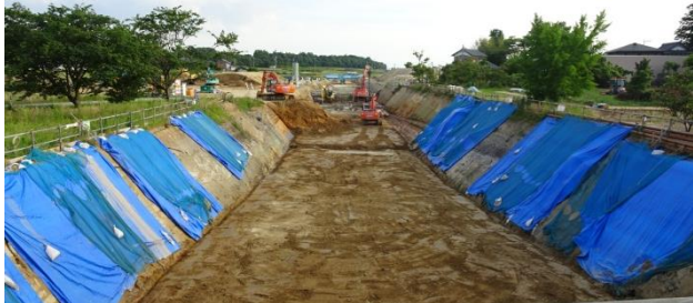
地盤改良工事（掘削）の様子
