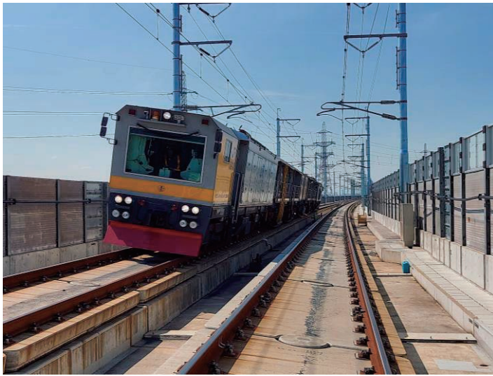
レール削正作業
