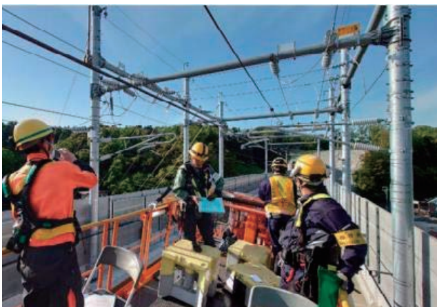
電車線の目視確認の様子
