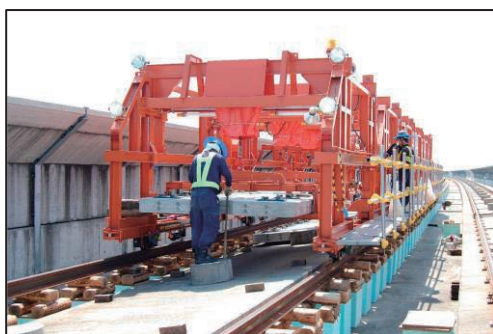
①軌道スラブの敷設
