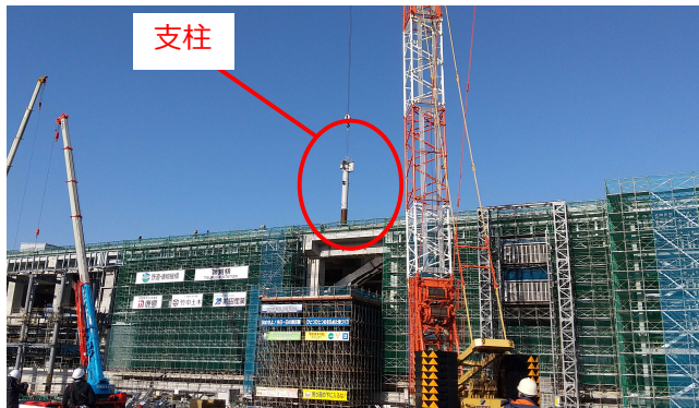
令和4年2月1日 敦賀駅の鉄骨組立作業開始
